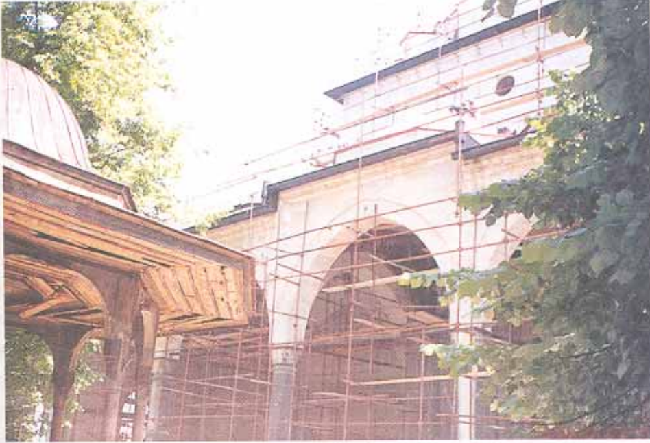
Tarihî Gazi Hüseyin Camii Restorasyon çalışmaları devam ediyor.
